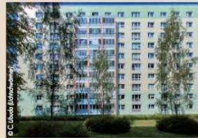
Mit der QP-Serie, eingeführt 1959, wurden erstmals in der DDR raumgroße Elemente verwendet, d. h. die Gebäude sind „Plattenbauten“ aus industrieller Fertigung. Es handelt sich um eine Querswandbauweise mit tragenden Innen- und Außenwänden. Die Giebelseiten wurden zum Teil offen mit Balkonen gebaut. Erstmals wurden Platten mit Schaumpolyester-Isolierung und außenseitigen Keramikplatten verwendet.
