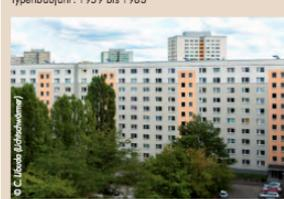
Beim QP wurden erstmals in der DDR raumgroße Elemente verwendet, d. h. die Gebäude sind „Plattenbauten“ aus industrieller Fertigung. Markant sind die außenseitig verwendeten Keramikplatten. Die beiden Gebäude S-wardstraße 173-179 und 209-219 werden seit Erstbezug als Studentenwohnheim genutzt und wurden auch zu diesem Zweck gebaut. Den privaten Zimmern sind gemeinschaftlich genutzte Küchen und Duschräume zugeordnet. Einzelne Zimmer haben Zugang zu einem eigenen Balkon.
