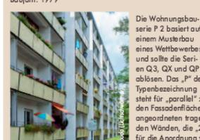
Die Wohnungsbauweise P 2 basiert auf einem Musterbau eines Wettbewerbes und sollte die Serien Q3, Q4 und QP ablösen. Das „P“ der Typenbezeichnung steht für „parallel“ zu den Fassadenflächen angeordneten tragenden Wänden, die „2“ für die Anordnung von zwei Aufgängen pro Gebäude.
