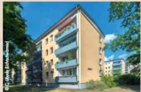
Der Bautyp QX wurde in Großblockbauweise - also noch nicht in Plattenbauweise - in Querswandbauweise mit Abschabständen zwischen 2,40 m und 3,60 m gebaut.
