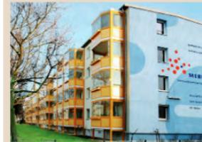
Mit Q3A begann 1957 die Serienproduktion der Großblockbauweise in Berlin. Es handelt sich per Definition noch nicht um „Plattenbau“, eine Wand bestand noch aus mehreren einzelnen Betonelementen.
